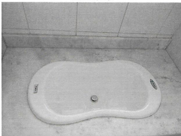
Pedra de Mármore para suporte da banheira
